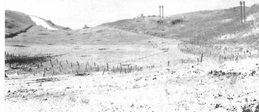
22 settembre 1944. Una visione panoramica delle fortificazioni tedesche (spesso costruite con manodopera italiana) che in questo caso sono costituite da tronchi di binario issati verticalmente e da pali di ferro profilato fissati sul terreno mediante una base di cemento armato. (NA Washington, III-SC-359056)
